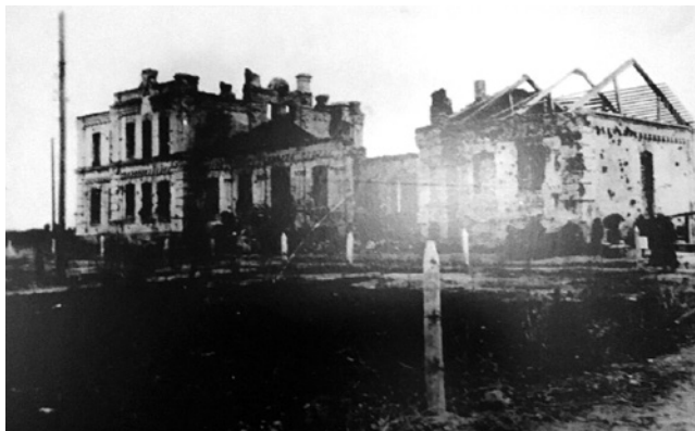
Станция Себряково, разрушенный вокзал, 1943 г.
